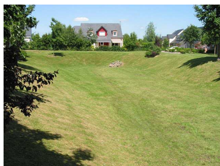
Illustration 55: Exemple de bassin de rétention
