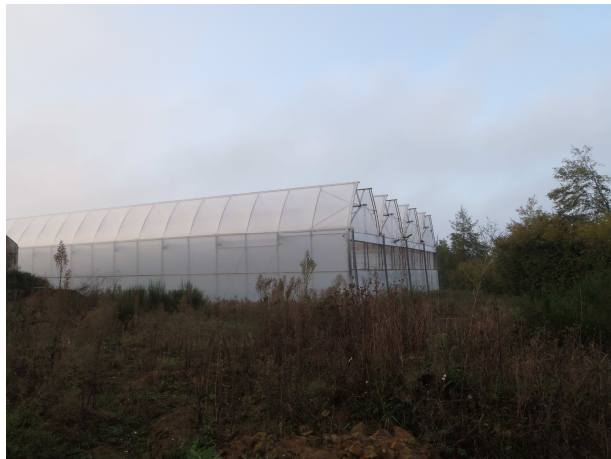
Photo n°5 : Serre R9, à 50 m
