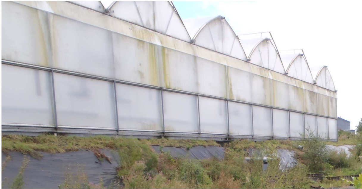
Illustration 56 : Serres déjà construites
